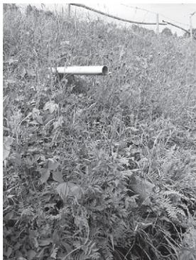
08 / 土手にパイプを通し、山手の田の水を北山水路（写真右下）に落とす
