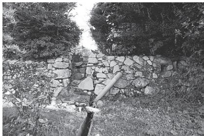
雨水と雑排水の排水溝（川に放流）（図6-F）
