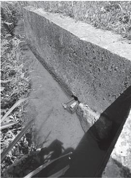
16 / 丸太の太さを調節して隙間を作り、配水量を加減している
