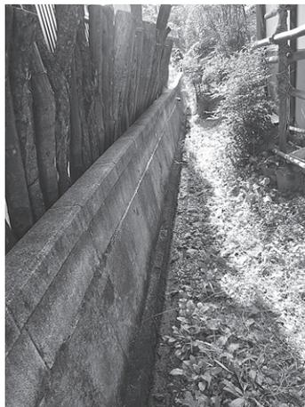
雨水と雑排水の排水溝（共同溝に放流）（図6-E）
