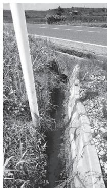
28 / 大倉水路の上を流れる県道脇の雨水側溝に、一番低い田の「ほかし水」が合流する
