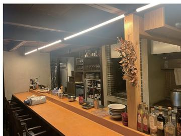
写真32 磨き仕上げのカウンターと新しい柱
