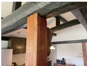
写真 32 「島村葎商店」古材で組み上げた柱
