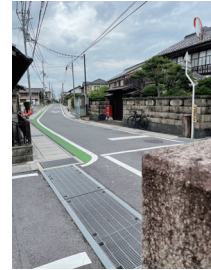
写真19 道標より街道を望む(中山道:京都方面)
