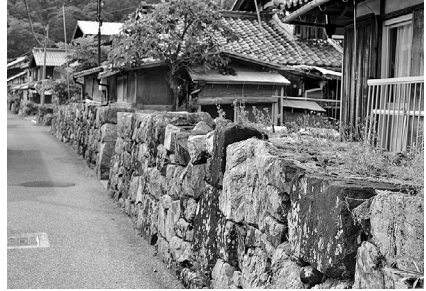
「波除石垣」。出入り口に開口部があり板が差し込まれるようになっている
