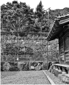
「阿弥陀寺」の穴太積み の石垣。特に立派な「盛土の石垣」である
