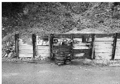
板でしっかり土留めをした水場。久太郎山の湧き水
