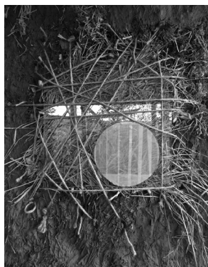
真実の窓 (truth window) の下地づくり (▲)
