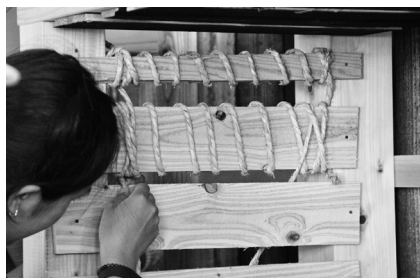
ニッチ側面の壁下地作り (○)
