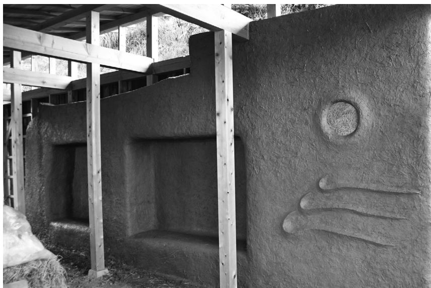
完成した藁と土の壁 (△)
