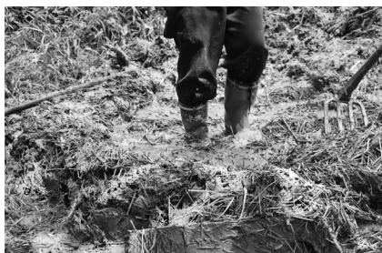
下塗り用の荒土と藁スサを足でこねて混ぜる (△)
