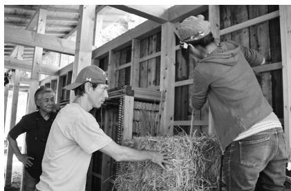
5 / ベイルを固定したら、竹串を2本ずつ2段分打ち込む (△)
