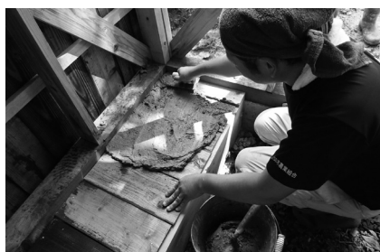
2 / 足元の板張りの上に土を薄く塗る。地面からの湿気を藁壁に伝えないため (▲)
