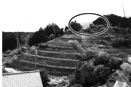
仰木道から八王寺山を望む。円内が建設地
