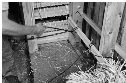
4 / ベイル1個当たり2本のシュロ縄を背後の横胴縁に縛り、ベイルを固定する (○)
