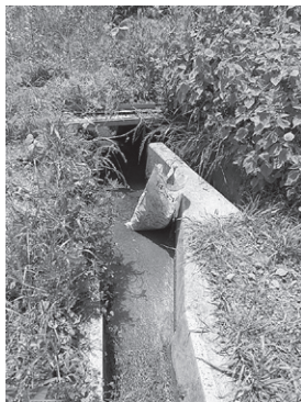
19／北山水路(写真中央)と小井堰(右)の分岐点。 閉じる時は土囊を積む
