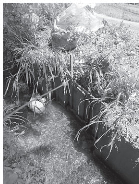
15／小井堰への分岐点に設けられた板。下の田に落とす水量を調節
