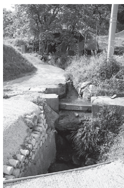
03／高所から引かれた小井堰と北山水路の合流 点。上からの水量が多い時はここで調節し て大倉川に戻す
