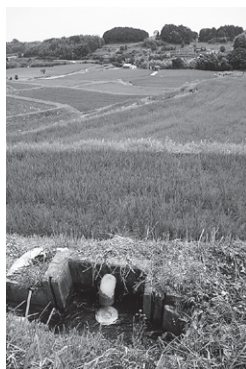
17／ここから先は北山水路の終点に近く、田への配水量の不足を補うために大倉川からポンプで揚水して補給している
