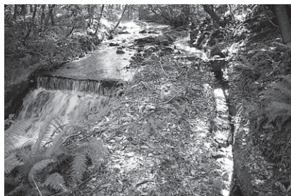
01／大倉川の取水口。北山水路（写真右・井堰） はここからはじまる
