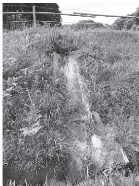
09／山手の田の水を直接土手の上に流して北山水路（写真下）に落とす
