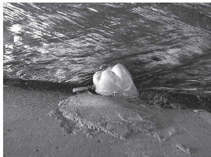
13／ペットボトルでふさぎ、流れを直進させる
