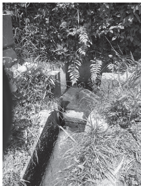
20／北山水路と下の田へ水を落とす小井堰との分岐点
