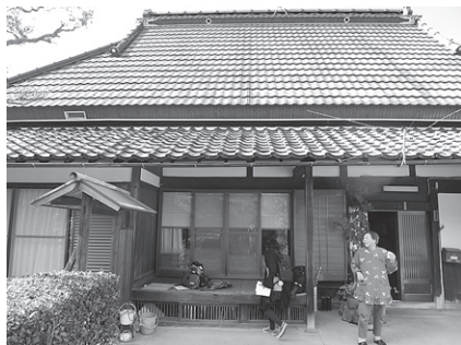
母屋正面の玄関と縁台
