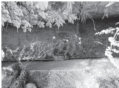
14／丸太の木切れを詰めて分水口をふさぐ
