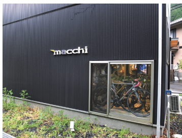
写真14 窓から自転車のがぞく店舗
