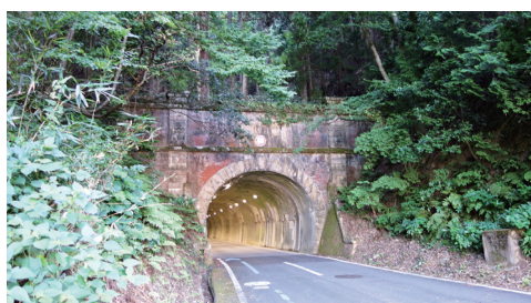
写真 31 煉瓦造りの賤ヶ嶽隧道
